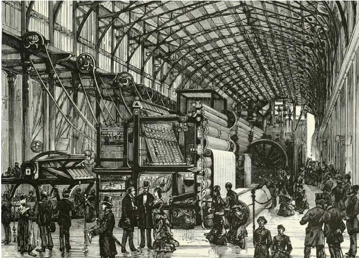
Figure 4. Vue Générale de la Galerie des Machines. Detail of Vue générale de la galerie des machines : image from Librairie illustrée, L'art et l'industrie de tous les peuples à l'Exposition universelle de 1878 , (Paris: Librairie illustrée, 1880) 409.
